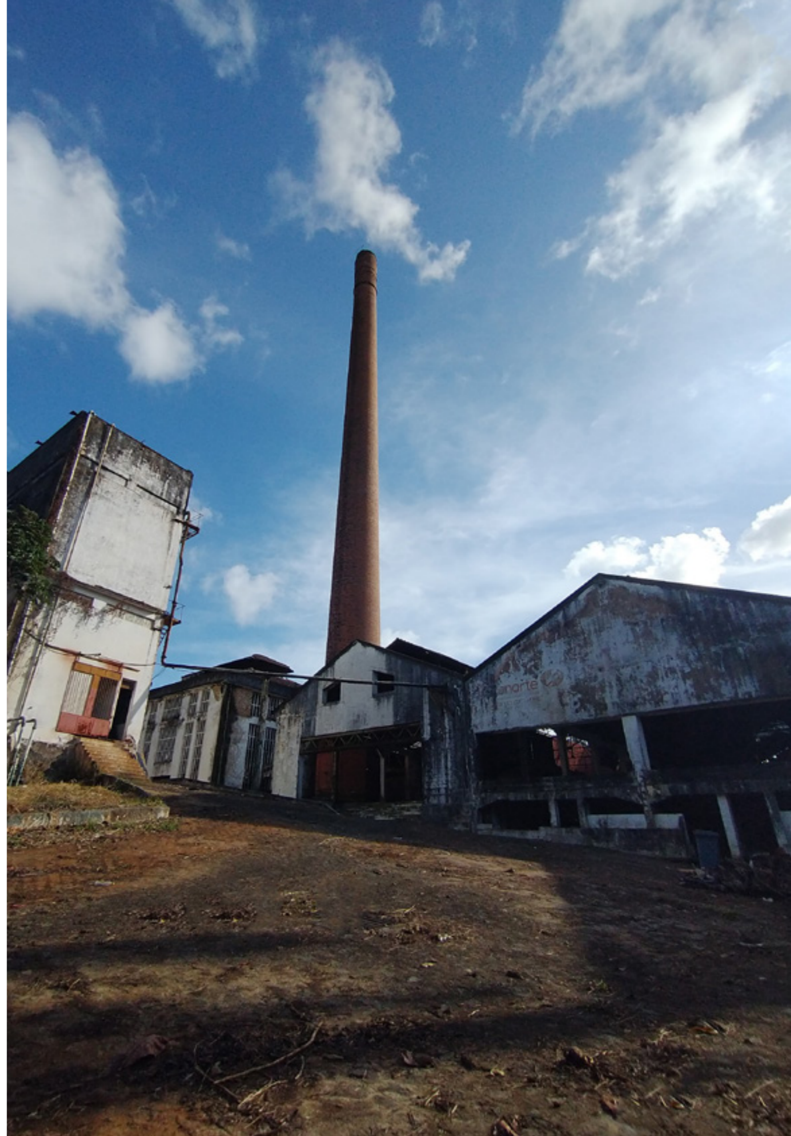
Figura 04 - Imagem externa do complexo com a chaminé em destaque. Fonte: Acervo próprio.
