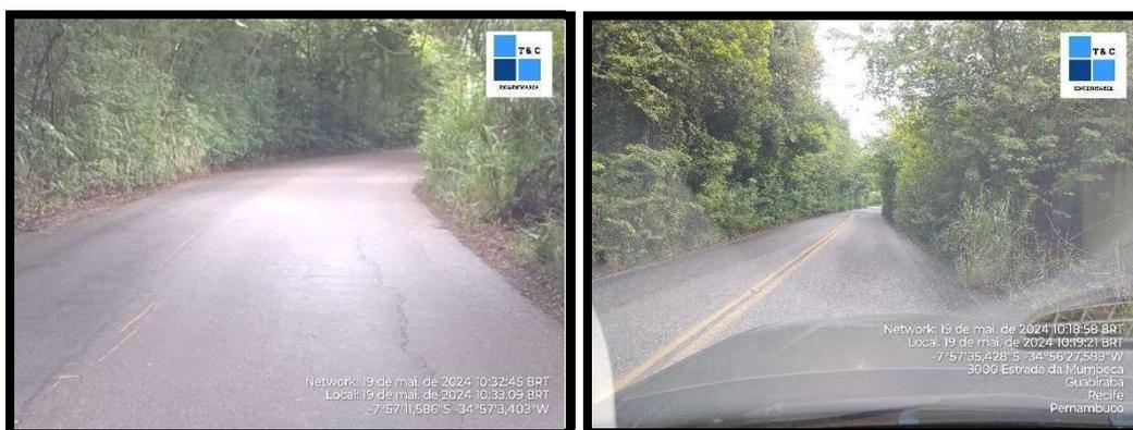
Fotografia 9 – Em vários trechos da PE-016, se apresentam sem acostamento e sem local para o deslocamento de pedestres.
