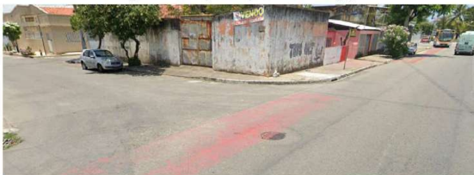
Imagem 4 – Foto do Poço de Visita da Interligação
