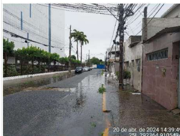
Foto 80 – Retenção de água na Rua Manoel Coriolano ainda em eventos de chuva moderada, revelando uma drenagem pluvial deficiente. Fonte: Héctor Díaz.
