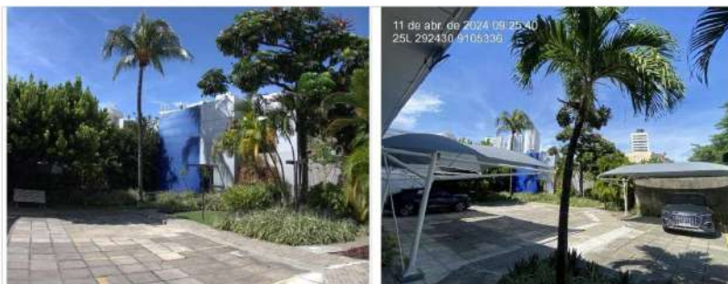
Foto 1 – Uso do solo 1 - Panorâmica das instalações da empresa Federal Energia, configurando o ossetor de maior impermeabilização do terreno. Fonte: Héctor Díaz.
