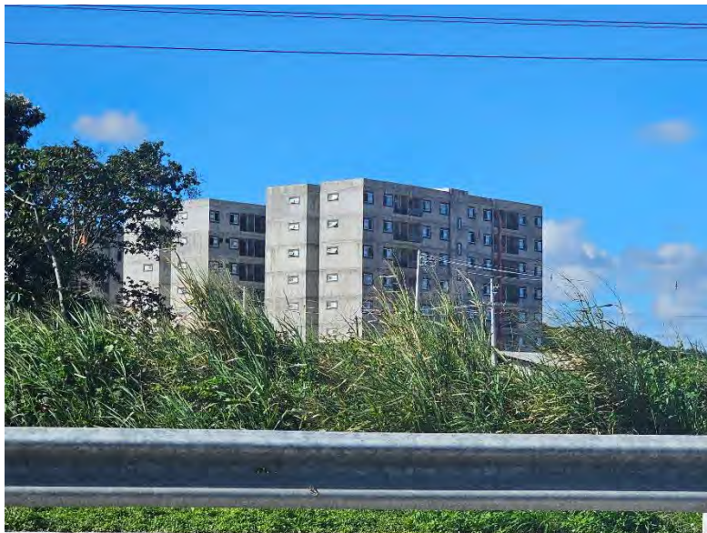
FIGURA 28 - CONJUNTO RESIDENCIAL EM OBRAS. FONE: GR PROJETOS - 2026.
