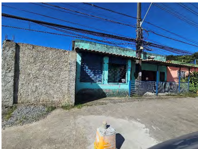
FIGURA 29 - FOTO DE OCUPAÇÃO IRREGULAR. FONTE: GR PROJETOS - 2026
