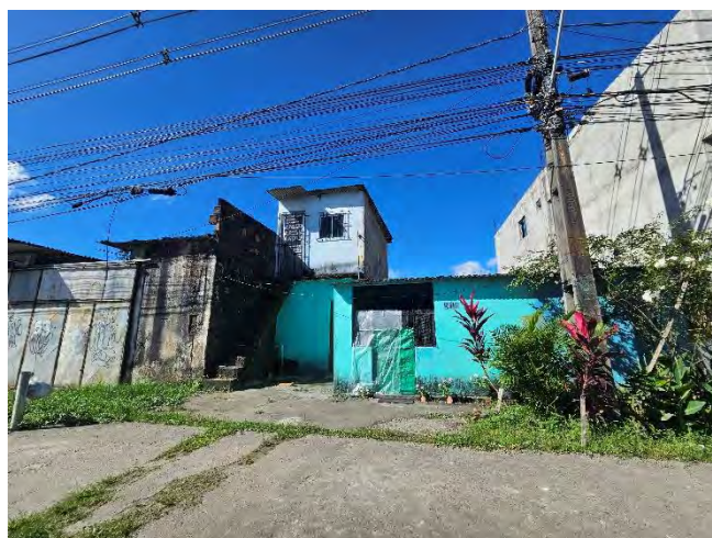
Figura 30 - Foto de ocupação irregular. Fonte: GR Projetos - 2026.
