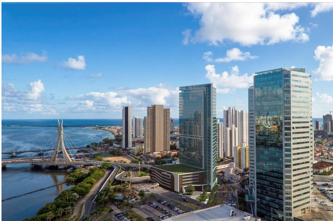
TORRE 6 - A ESQUERDA BACIA DO PINA E PONTE ESTAIADA EM SEGUNDO PLANO.
