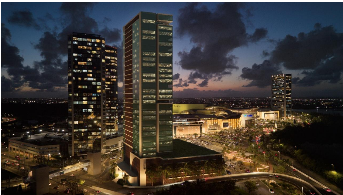
TORRE 6 – COM ALÇA ELEVADA DE ACESSO AOS EMPRESARIAIS 1, 2 E 3 EM PRIMEIRO PLANO
