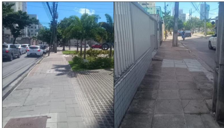
Figura 16: Calçada 7 (esquerda) e calçada 8 (direita) - R. Nogueira de Souza
