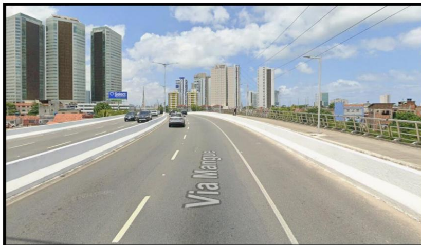
Figura 22: Ciclovia Via Mangue.
