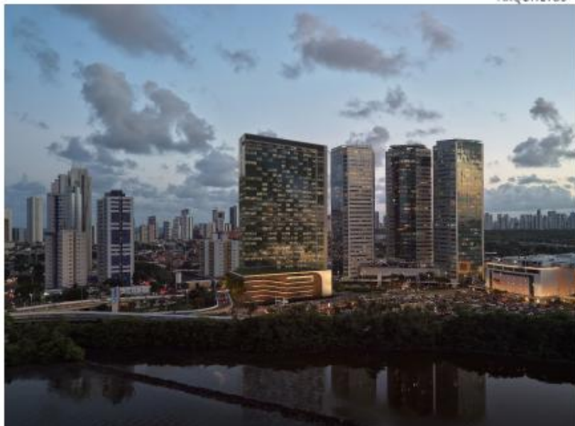
TORRE 6 - IMPLANTADA AO LADOS DAS TORRES 1, 2 e 3 EXISTENTES.
