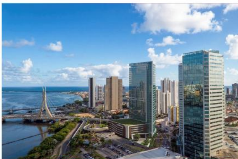
TORRE 6 - A ESQUERDA BACIA DO PINA E PONTE ESTALADA EM SEGUNDO PLANO.
