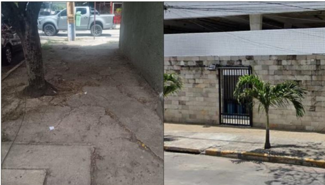
Figura 17: Calçada 9 e 10 - Av. República Árabe Unida
