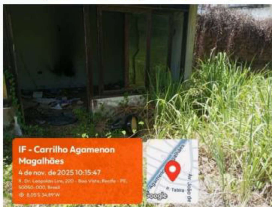
Figura 12 - Estrutura de piscina, área de serviços
