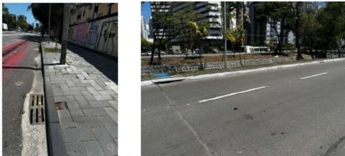
Figura 11. Galerias na Avenida Agamenon Magalhães localizadas em frente do empreendimento.
