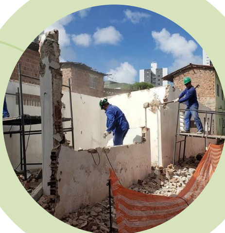
Figura 10. Demolição de edificação para PCR Fonte. AC Demolidora
