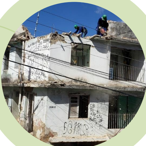
Figura 26. Demolição de edificação para PCR Fonte. AC Demolidora
