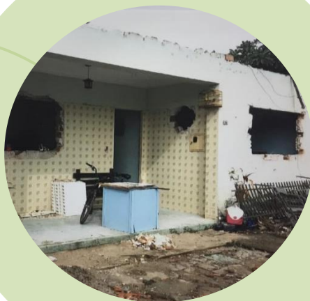
Figura 8. Demolição seletiva de edificação em Recife Fonte. Emlurb Recife/PCR
