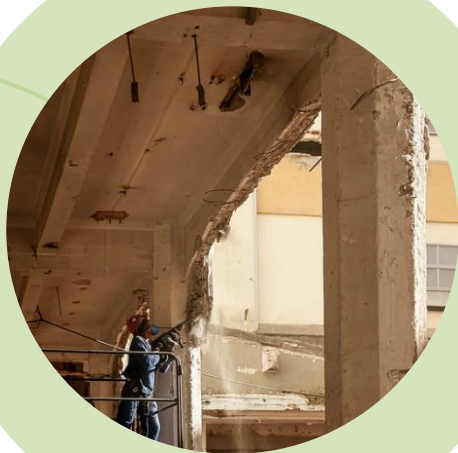
Figura 3. Demolição de estruturas no Recife Antigo Fonte. Andréa Rêgo Barros/PCR
