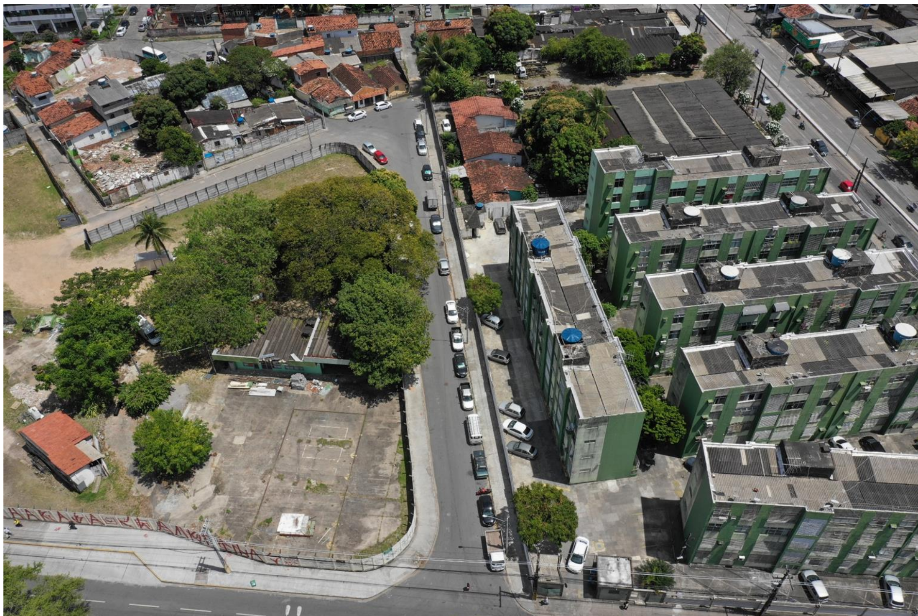
VISTA RUA DA AREIA EXECUTADO.
