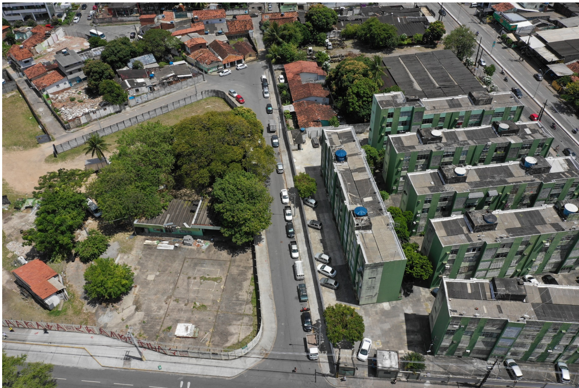
VISTA RUA DA AREIA EXECUTADO.
