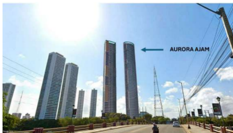
Figura 03 - Imagem das duas torres, a partir da ponte Limoeiro. Fonte: EIV apresentado.
