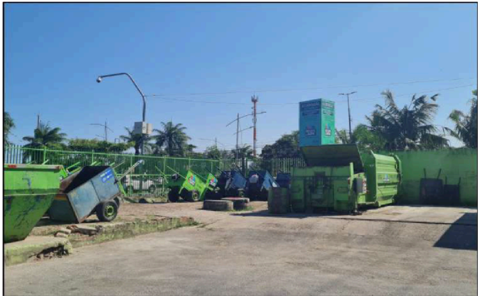
Figura 41: Estrutura e equipamentos na Ecoestação Agamenon
