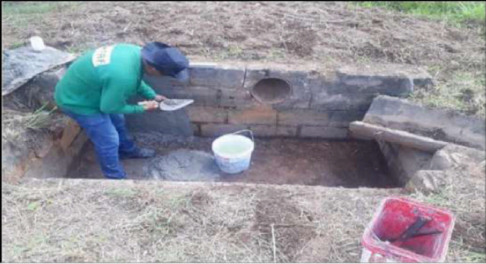
Figura 64: Atividades de manutenção do aterro encerrado da Muribeca: manutenção da caixa de passagem
