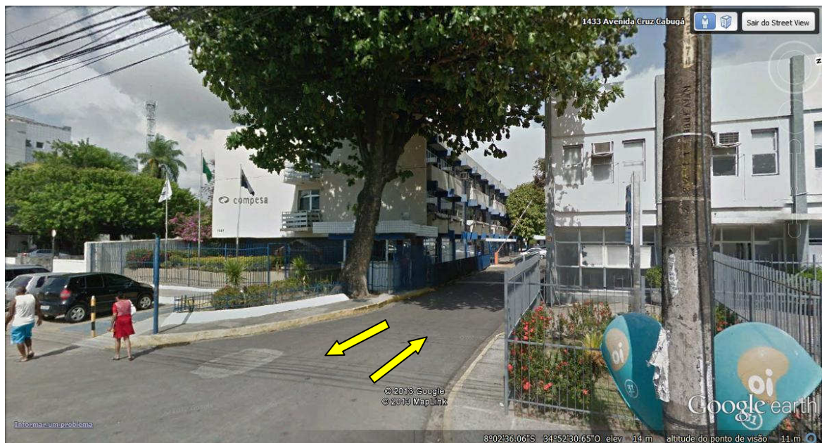
Vista do acesso atual da COMPESA na Av. Cruz Cabugá a ser desativado para veículos.
