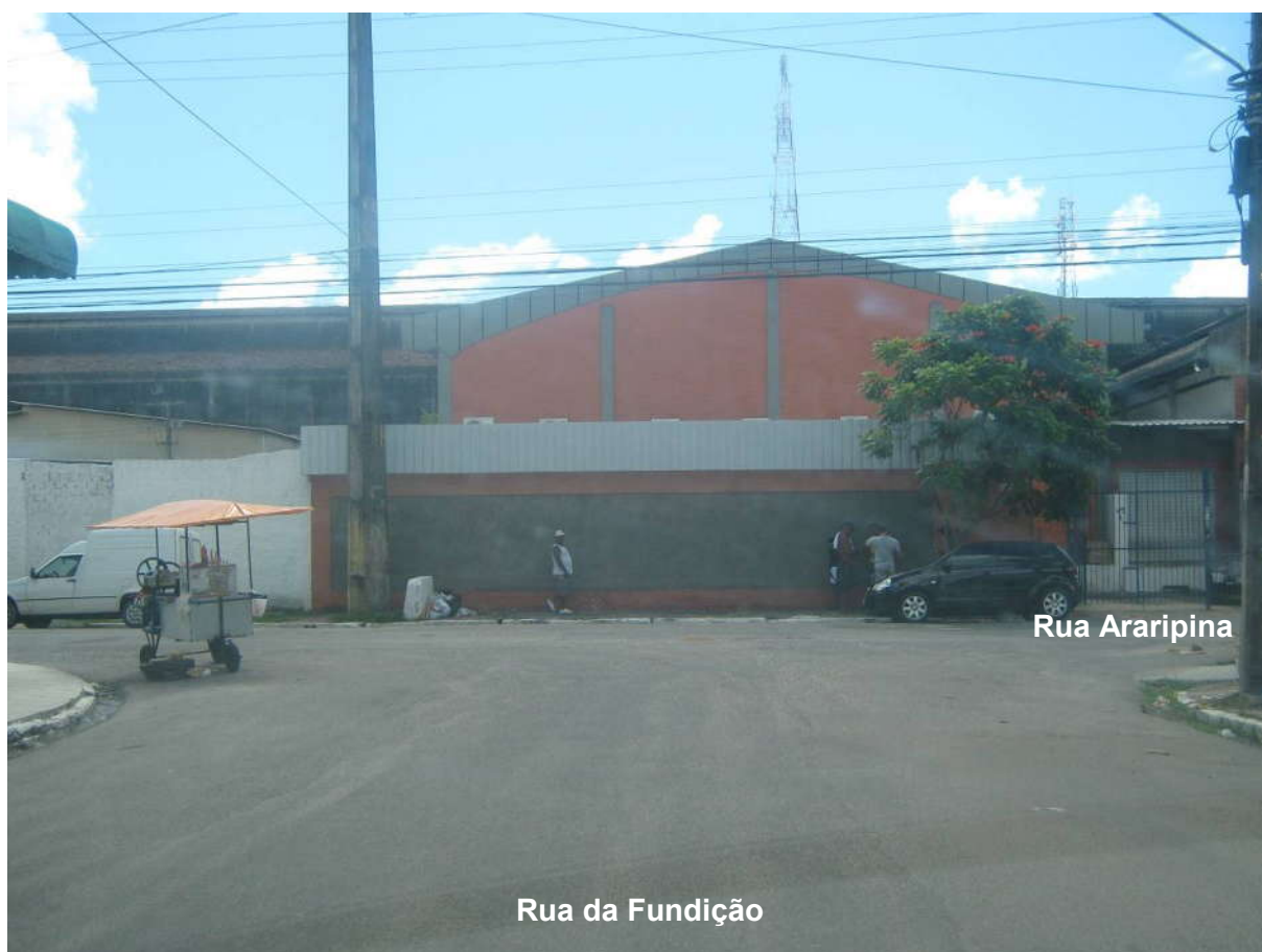
Cruzamento da Rua Araripina com Rua da Fundação
