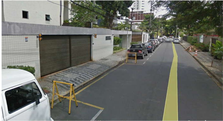
Figuras 06 – Vista Geral do Portão de Acesso
