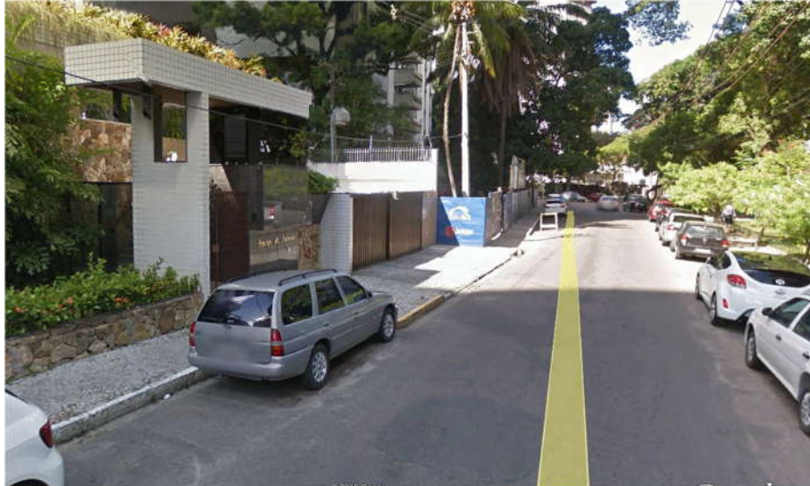
Figuras 07 – Vista Geral do Portão de Acesso
