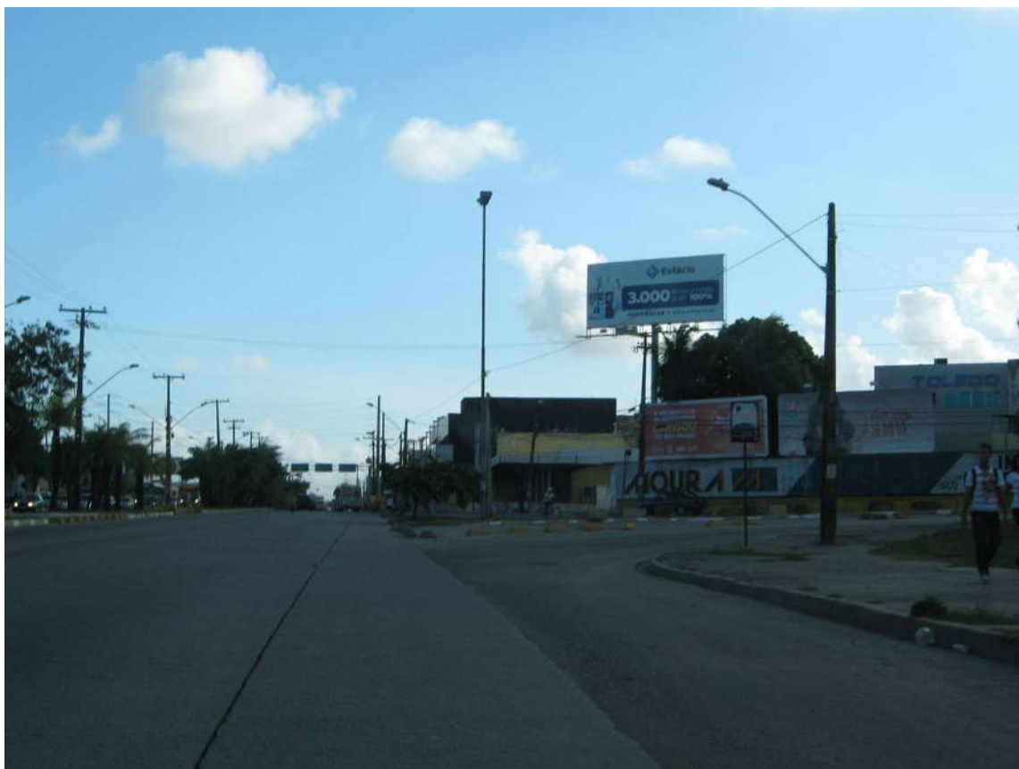
Av. Mal. Mascarenhas de Moraes Alça Sul de Acesso p/ Boa Viagem
