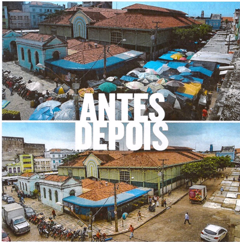
17. TRAVESSA DO MACEDO - Tinha 12 (doze) prédios construídos na rua, derrubamos tudo e estão desocupadas e livres.
