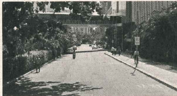
Figura 3 - Sombreamento deficiente falta de calçada junto ao canal
