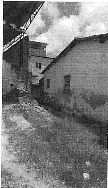
Vista do imóvel na lateral esquerda
