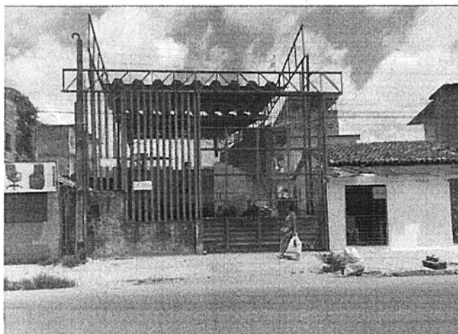
Vista da fachada do Galpão.
